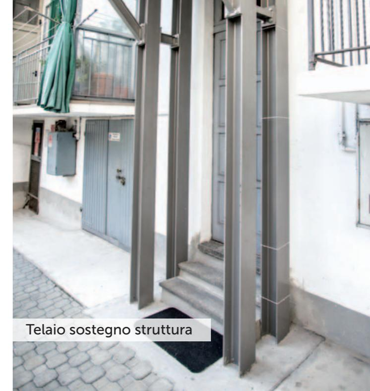
Telaio sostegno struttura
