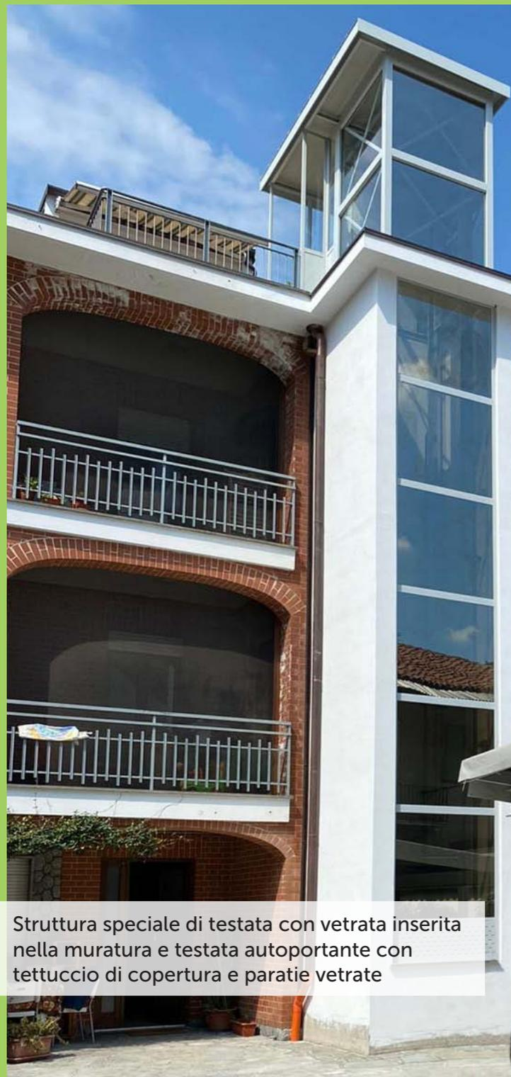
Struttura speciale di testata con vetrata inserita nella muratura e testata autoportante con tettuccio di copertura e paratie vetrate
